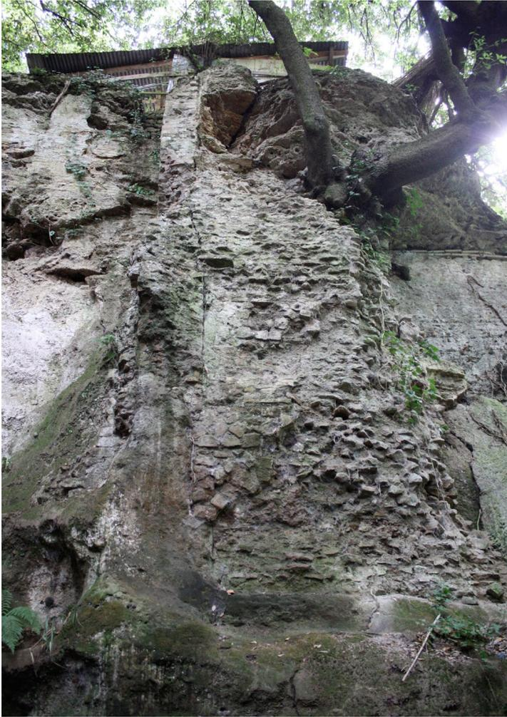
Sezione della spalla orientale della diga lungo il Fosso di Caipoli (Galliciano, RM) con il dettaglio delle fondazioni.
